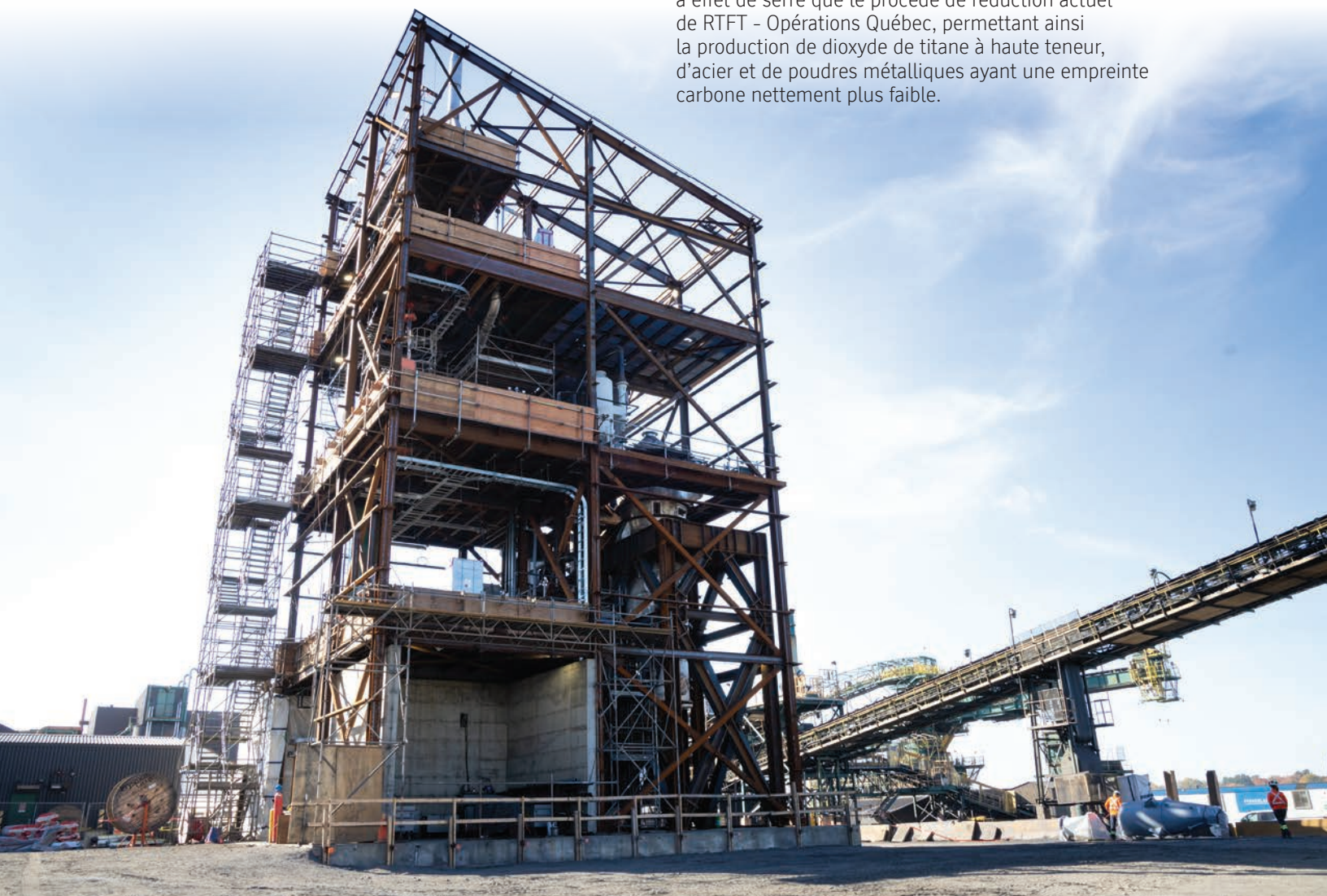
L'Usine BlueSmelting en construction.
